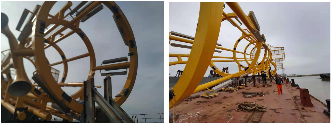
图 2-3 牺牲阳极焊接安装在套笼上
