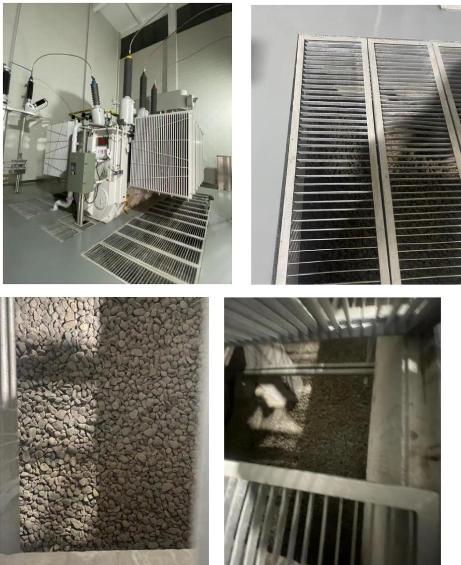
图 8-3 变压器及下方鹅卵石层
