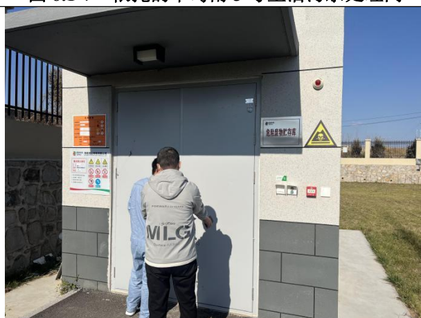
图 6.1-9 依托的危险废物贮存库房
