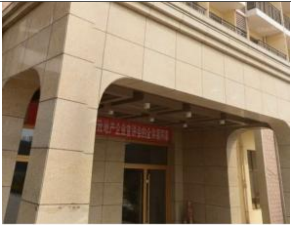
图 6.1-4 施工单位租赁小区
