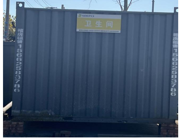
图 6.1-2 陆上集控中心施工期环保厕所
