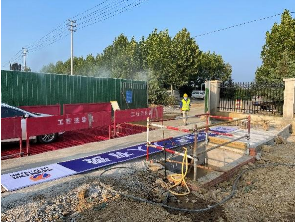
图 6.1-1 施工围挡、洗车平台、除尘装置
