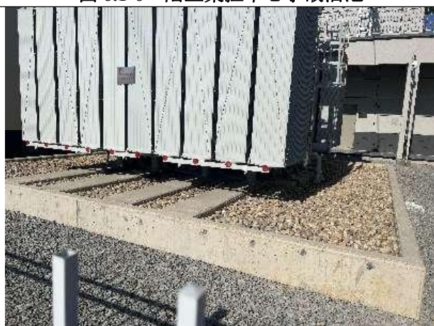
图 6.1-8 主变接地、降噪
