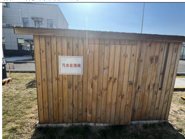
图 6.1-7 依托的半岛南 3 号生活污水处理间
